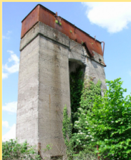
Château d'eau de l'ancienne fonderie
