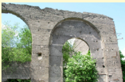
Mur de l'ancienne fonderie
