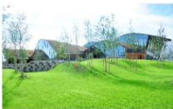
À Mantes-la-Jolie, Aqualude, un équipement dédié aux prestations ludiques et sportives.
